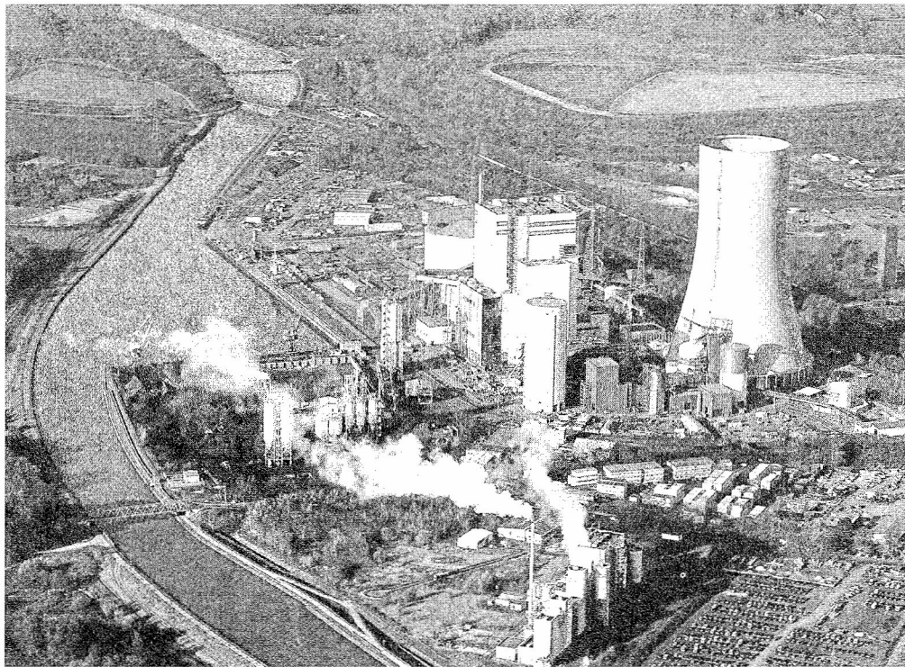
Die Baustelle für das Trianel-Kraftwerk im Lüner Stummhafen
