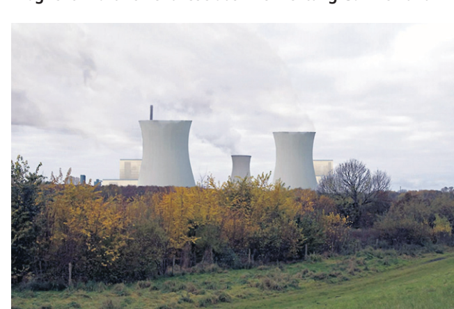
... aus Blickrichtung Alstedde. Foto-Montage BI Kontra Kohle Kraftwerk
