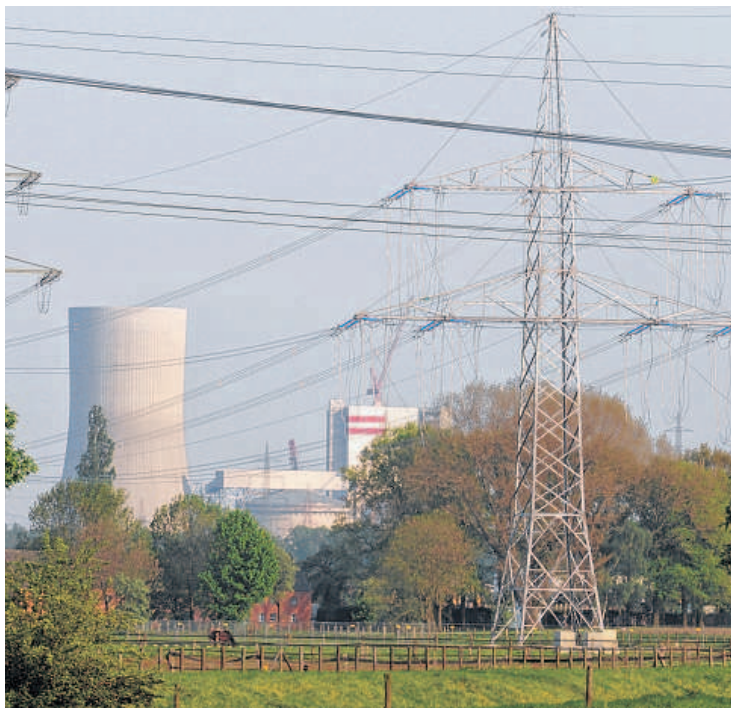
Stand der Dinge: In diesen Wochen werden noch Seile für die Hochspannungsleitung zum Anschluss des Kraftwerks gespannt. Foto: Trianel
