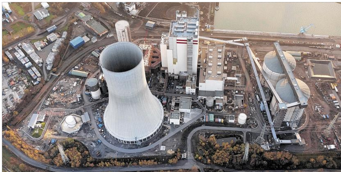
Der Bau des Kraftwerks ist weit fortgeschritten. Trianel wird alles tun, um die Umweltverträglichkeit doch noch nachzuweisen. Foto: Hans Blosssey
