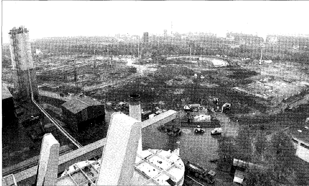
Was hier im Stummhafen wächst, sorgt in der Schweiz für Proteste: Die Baustelle für das Kohlekraftwerk im Stummhafen. (Foto: Trianel)
